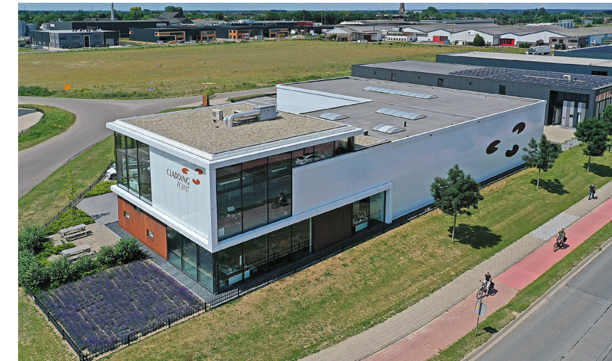
Cladding Point Elst.
