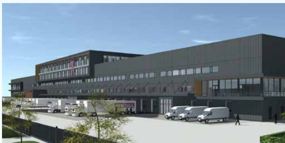
Project: Rent-All, Bommel. ca. 16.000m 2 BL Alpha-AR sandwichpanelen. Uitgevoerd met lengtes tot 18.000mm. Montage: Hardeman & van Harten B.V., Lunteren.
